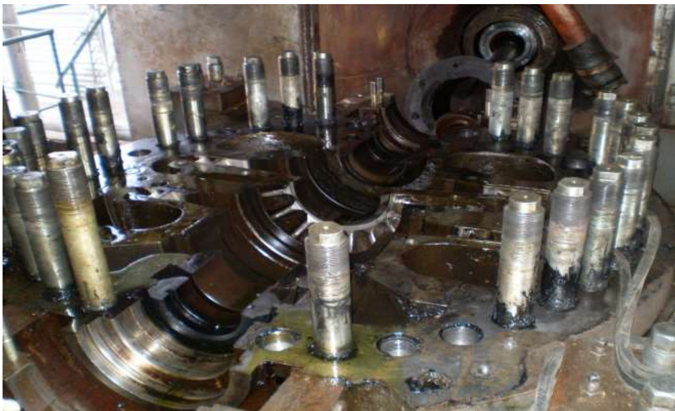
Общий вид после вскрытия ЦБН агрегата типа ГПА-Ц-6,3
